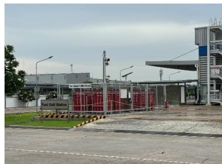
รูปที่ 53 รั้วโพร่งรอบพื้นที่จัดเก็บถังก๊าซไฮโดรเจน
