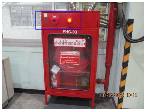
รูปที่ 40 สัญญาณแจ้งเหตุเพลิงไหม้อัตโนมัติ และปุ่มกดแจ้งเหตุเพลิงไหม้
