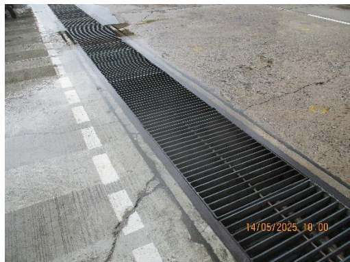
รูปที่ 12 รางระบายน้ำรอบพื้นที่โครงการ
