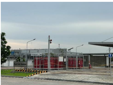
รูปที่ 53 รั้วโพร่งรอบพื้นที่จัดเก็บถังก๊าซไฮโดรเจน
