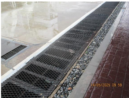
รูปที่ 12 รางระบายน้ำรอบพื้นที่โครงการ
