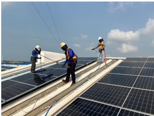
รูปที่ 57 กิจกรรมการล้างแผงเซลล์แสงอาทิตย์
